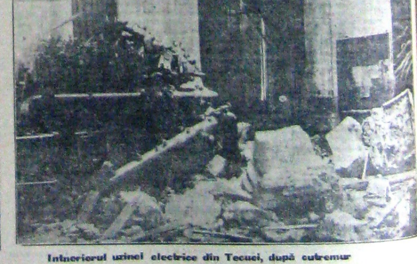
Interiorul uzinei electrice din Tecuci, după cutremur
